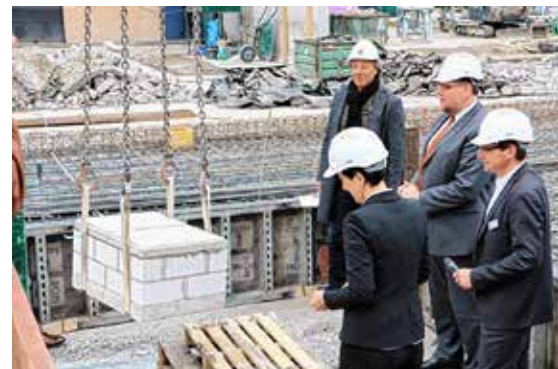
Bei der Grundsteinlegung des neuen Kunden-zentrums.
