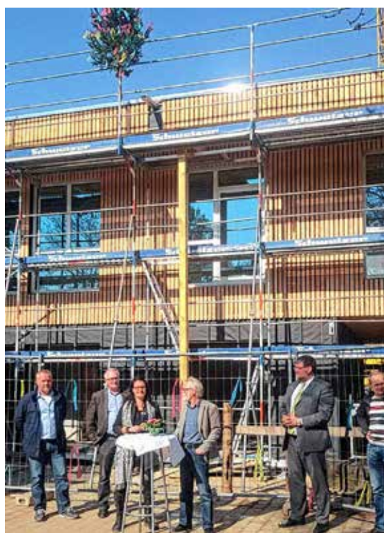
Richtfest für die Erweiterung des Kinderhauses Brühlstraße.
