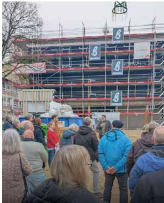
Beim Richtfest des neuen NWT-Trakts am Dietrich-Bonhoeffer-Gymnasium.
